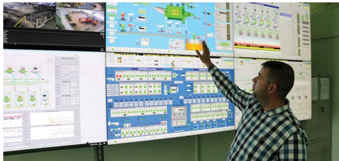
Автоматизирано управление на обогатителната фабрика
