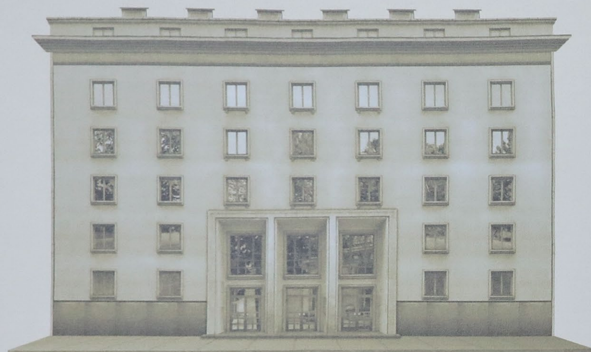
Сградата на нашия университет от 1924 г. до 1975 г. на ул. „Стефан Караджа“, свързана в единен комплекс чрез вътрешен двор със сградата на ул. „Г.С. Раковски“
