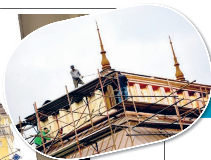
Панелите на покрива ще бъдат заменени с медни, а догодина вследствие на атмосферните условия ще придобият облик на благородна патина
