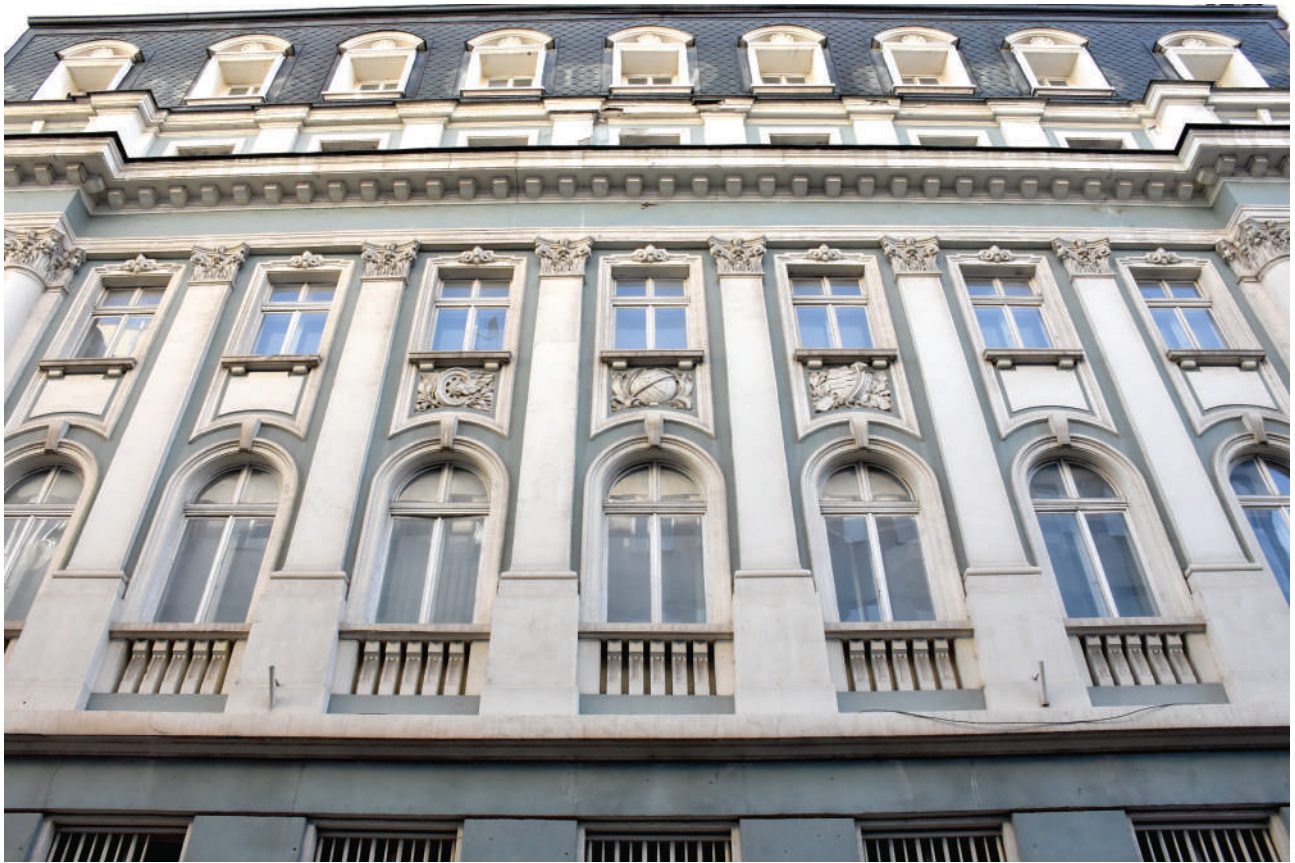
Банката на Кюмджийски на ул. „Лега“
