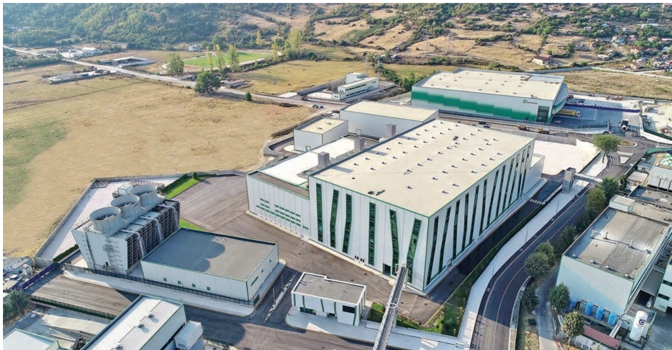
През септември 2019 г. беше открит ферментационен завод на „Биовет“ АД в Пещера. Главен изпълнител на строителството е „Главболгарстрой“, периодът на изграждането е под 2 години. Общата инвестиция възлиза на 150 млн. евро.
